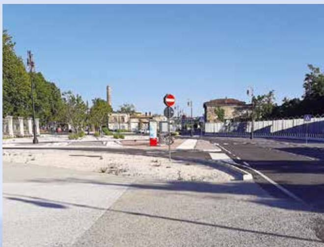
L'accesso al parcheggio dalla rotonda di Viale Miramare o dal Porto Vecchio
